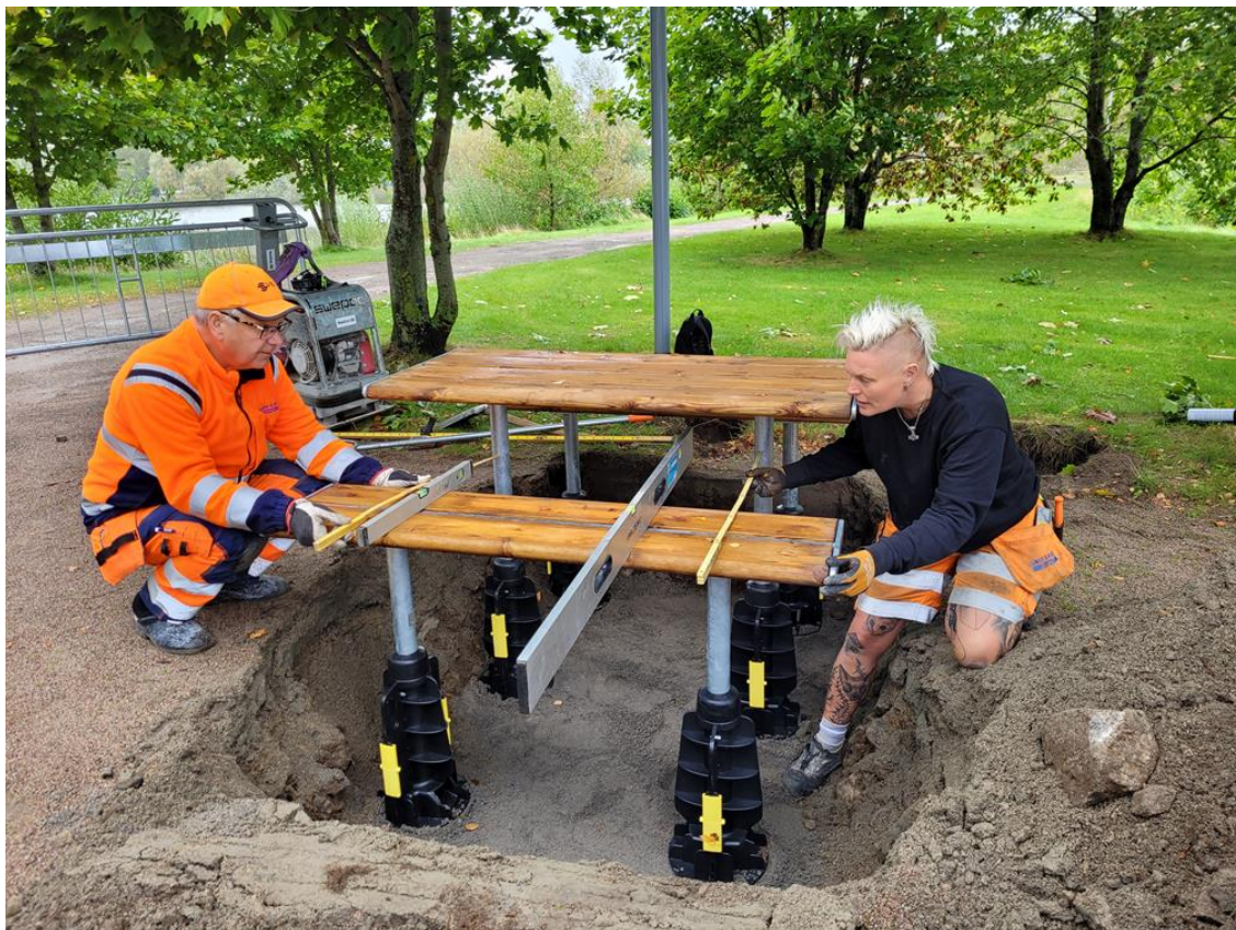
Figur 13. Installation av parkbänk med Quick Eco Base 60. Den låga vikten gör arbetet mycket enklare då fundamentet monteras på stolparna direkt och sedan kan allt justeras som en enhet.
